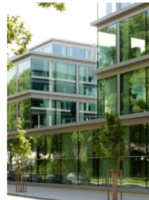
Wiel Arets Architects, Schwäbisch Media, Allemagne
